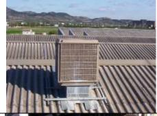
El principio de funcionamiento es por descarga de agua por gravedad. El equipo no produce aerosoles como parte de su funcionamiento normal.
