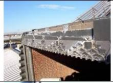
En su caída, por la geometría del equipo el agua se dispersa y se derrama sobre el relleno.
