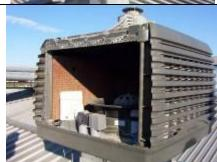
Detalle del punto de descarga del agua. El agua como se aprecia, se deja caer por gravedad, no se pulveriza.
